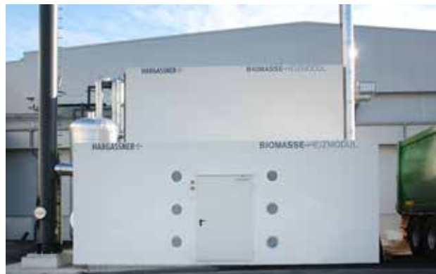
Module de chauffage multiple 660 kW bois déchiqueté, industrie
